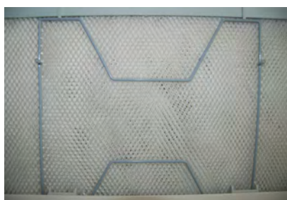
Pilt 32: Filtriklambri paigaldamine
