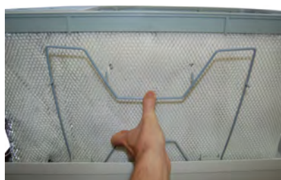
Pilt 28: Filtri kinnitusklambri eemaldamine
